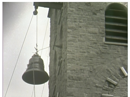
Aufzug der neuen Glocken in den Nordostturm der Abteikirche (Foto: Benediktinerabtei Münsterschwarzach).
