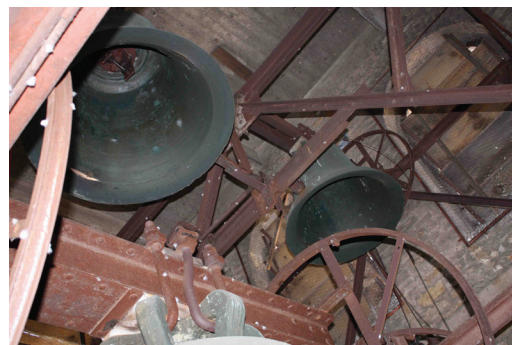
Blick in den stählernen Glockenstuhl zu Beginn der Umbauarbeiten (Foto: Br. Richard Maria Kuchenbuch OSB).
