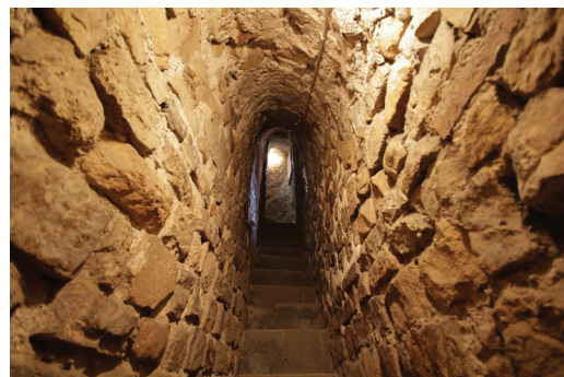
Das monolithische Mauerwerk des Turms.
