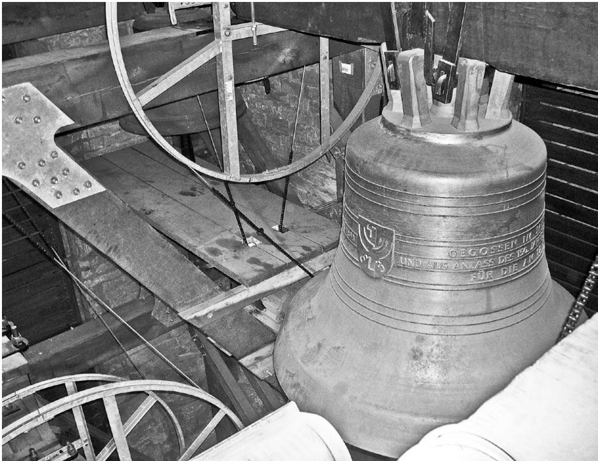
Die neue Jubiläumsglocke im durch Knotenbleche und Schrauben entstellten Holzglockenstuhl. Photo: Rüdiger Pfeiffer-Rupp 2006.
