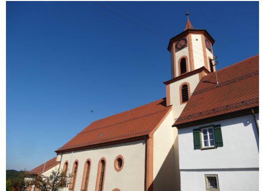
Außenansicht der Kirche (alle Photos: Daniel Orth).
