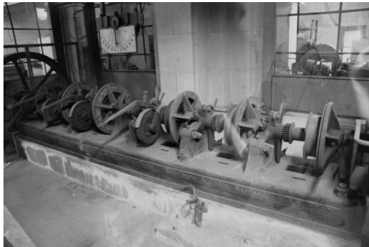
Abb. 3: Erste Läutemaschine des Kölner Doms, 1909 gebaut durch die Herforder Elektrizitätswerke (Photo: Sebastian Wamsiedler).
